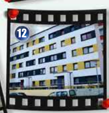
(12) 2016 - Wolframsdorffstraße 11 - 15 Komplettsanierung mit barrierearmem Zugang
