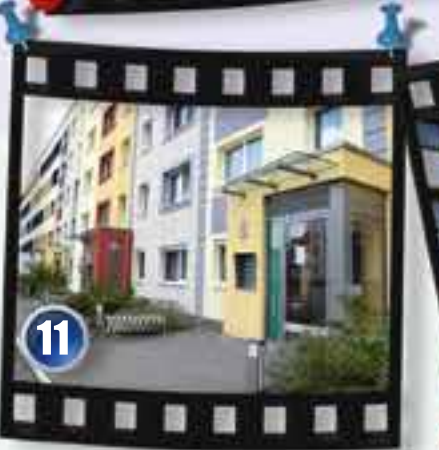
(11) 2012 - Wolframsdorffstraße 1 - 9 Komplettsanierung mit barrierearmem Zugang
